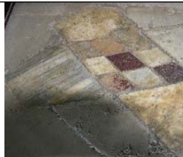
18. Tessitura diagonale. Tessere romboidali uniformi e scomposte in 9 elementi romboidali minori colorati: giallo, porfido, bianco.
